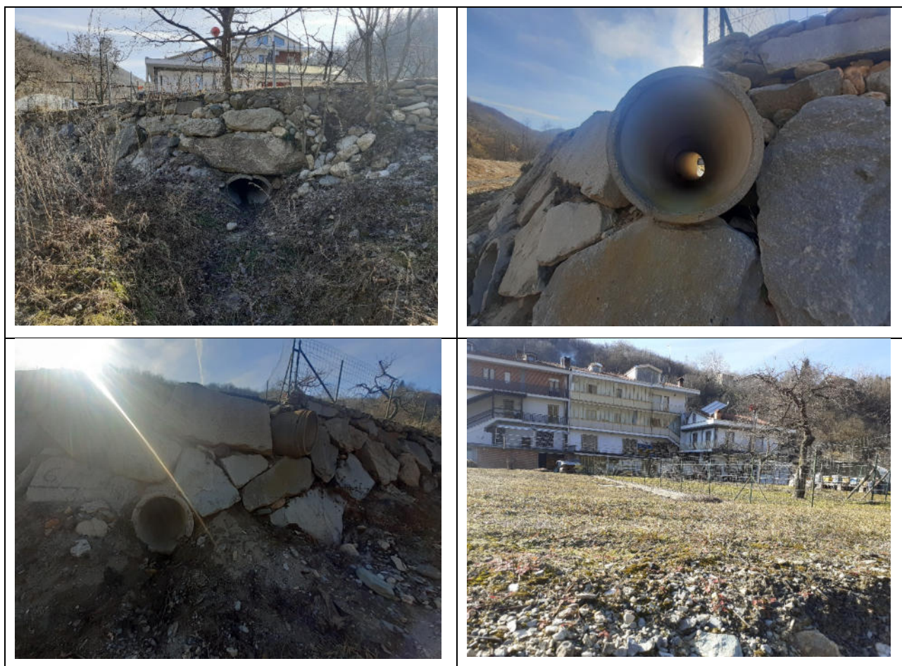
Figura 13-5 – Mantellata a protezione della sponda sinistra e condotti di scarico delle acque meteoriche delle due distinte aree edificate (foto 3284-20220205_141900, 142302, 142315, 142359)
