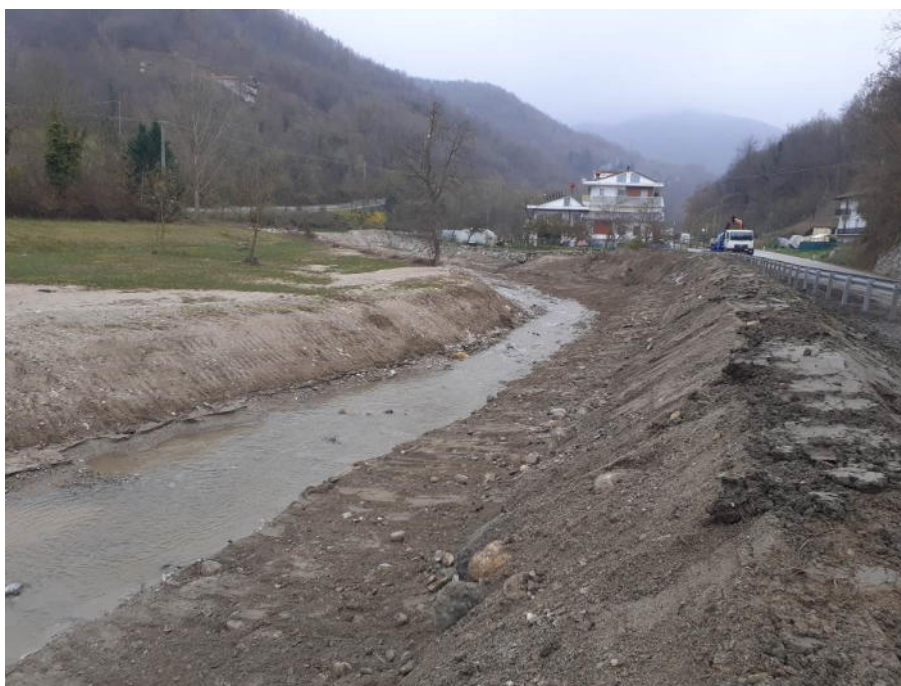
Figura 13-3 – Vista verso monte della sponda a valle dell'area edificata con la scogliera ricostruita. Si osservino, sulla sponda opposta, i depositi di sabbia a indicare l'estensione della sommersione (foto 2964- 20201112_155922)
