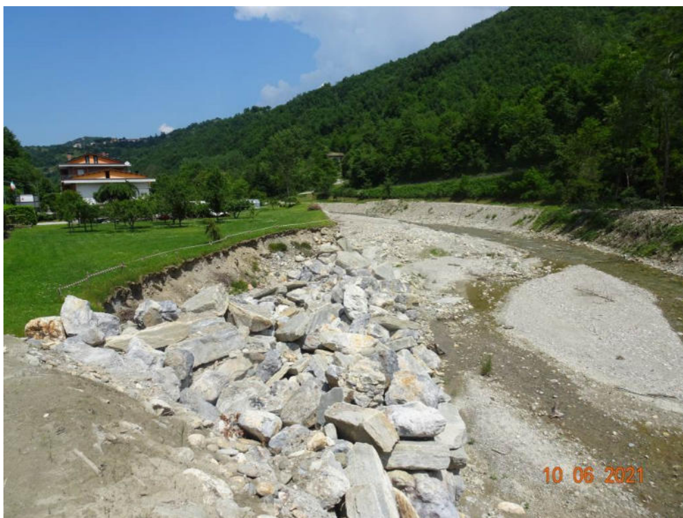
Figura 13-2 – Porzione di sponda sinistra a monte dell'area edificata asportata dall'evento del 2020 e, in primo piano, i blocchi accumulati in emergenza a protezione del tratto di sponda (foto 3113 - DSC04892)
