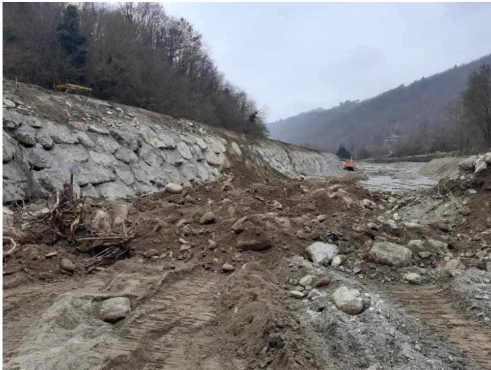
Figura 13-1 – Tratto di monte della scogliera lungo la strada provinciale in corso di costruzione dopo l'asportazione della sede stradale (foto 2964- 20201112_154900)
