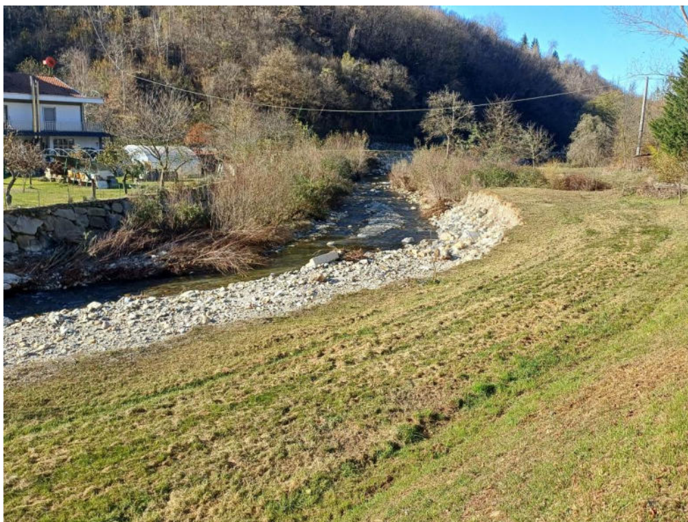
Figura 13-6 – Situazione dell'alveo di fronte all'area edificata. Si osservano gli abbancamenti di materiale sedimentario in centro alveo e la lunata in erosione che, se non controllata, andrebbe ad intaccare la stabilità della strada una volta asportato tutto il terreno in piano (foto 4232-20241122_133244)
