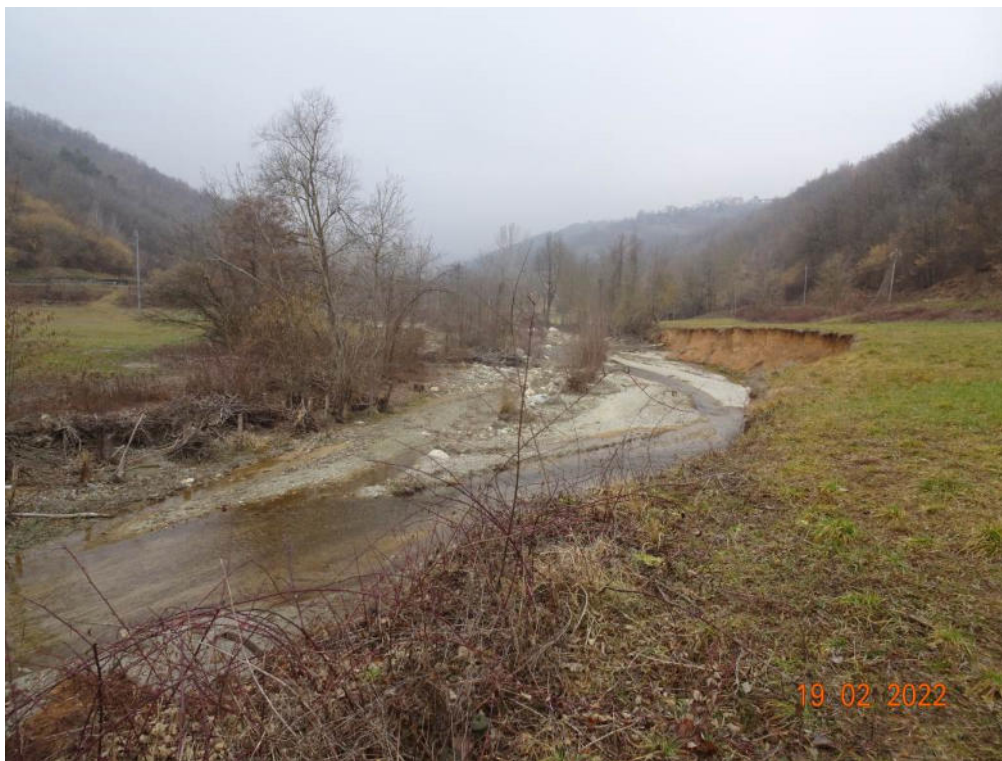
Figura 13-10 – Erosione della sponda destra in comune di Scagnello a valle dell'intervento di ricalibratura dell'alveo dove si opererà con il ritombamento del materiale in esubero dalle operazioni di movimento terra (foto 3297-DSC06439)
